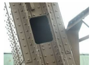
Rivets sur pilier de la Tour Eiffel
